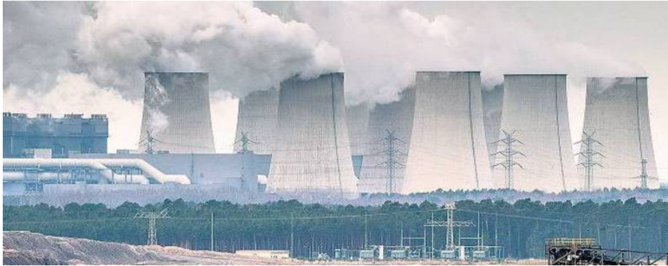
Mondlandschaft mit Kühltürmen. Der Braunkohletagebau und das Kraftwerk Jänschwalde produzieren viel Kohlendioxid. Im Sinne des... FOTO: PATRICK PLEUL/PICTURE ALLIANCE / DPA
